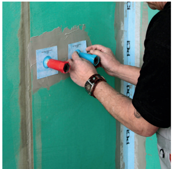
2. PCI Pecitape 10 x 10 über den aus der Wand herausstehenden Rohranschluss stülpen und mit PCI Lastogum (grau) verkleben.
